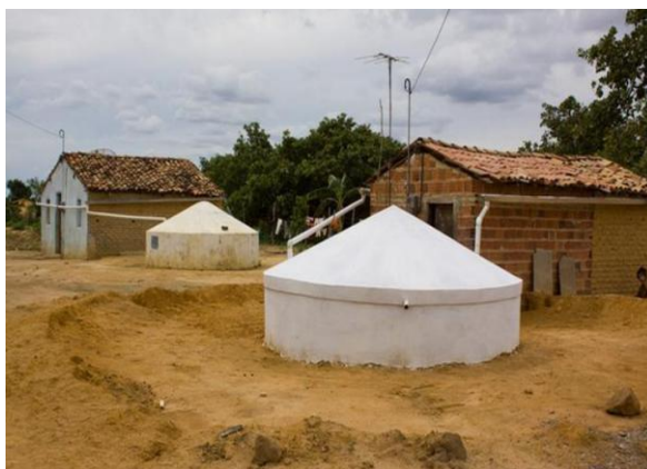
Figura 2 - Cisternas de placas instaladas em residência na comunidade de Serra Grande, em Serra Talhada – PE. Fonte: Lima, 2014.
